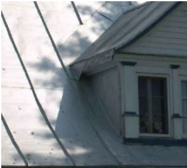
Figure 17 : Toiture en tôle pincée ou agrafée
