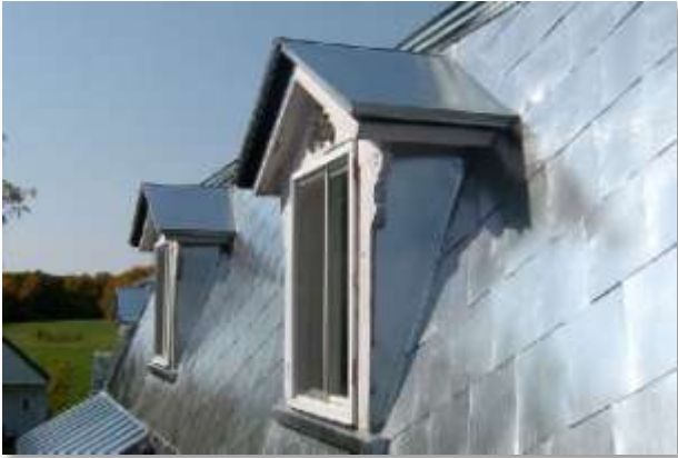
Figure 16 : Toiture à la canadienne
