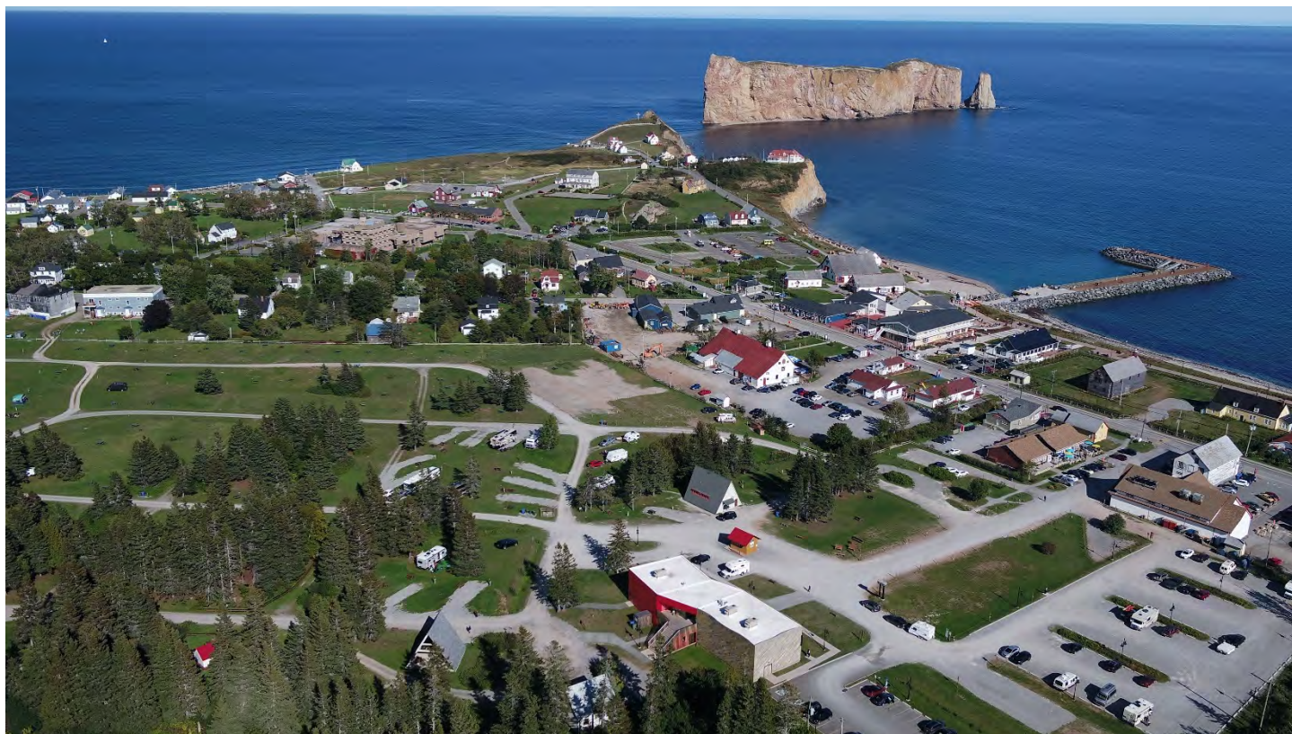
Figure 12 Terrain récréatif municipal et infrastructures du Geoparc
