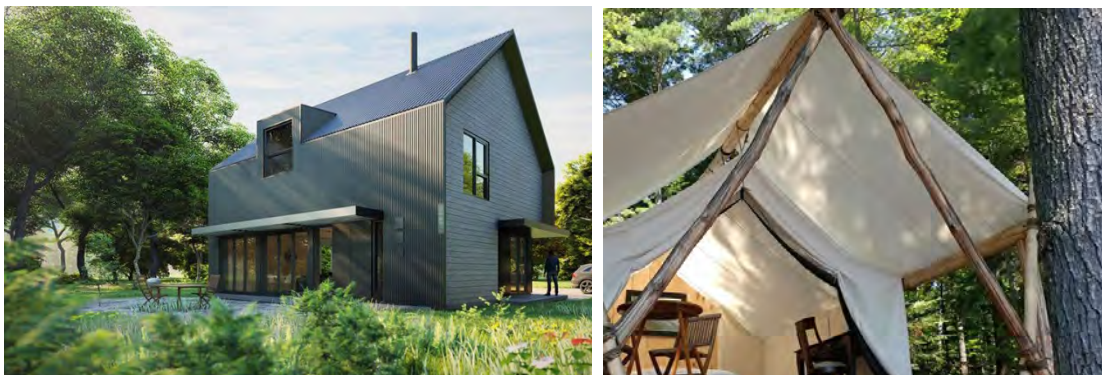
Figure 16 Bâtiment écologique et infrastructures et glamping
