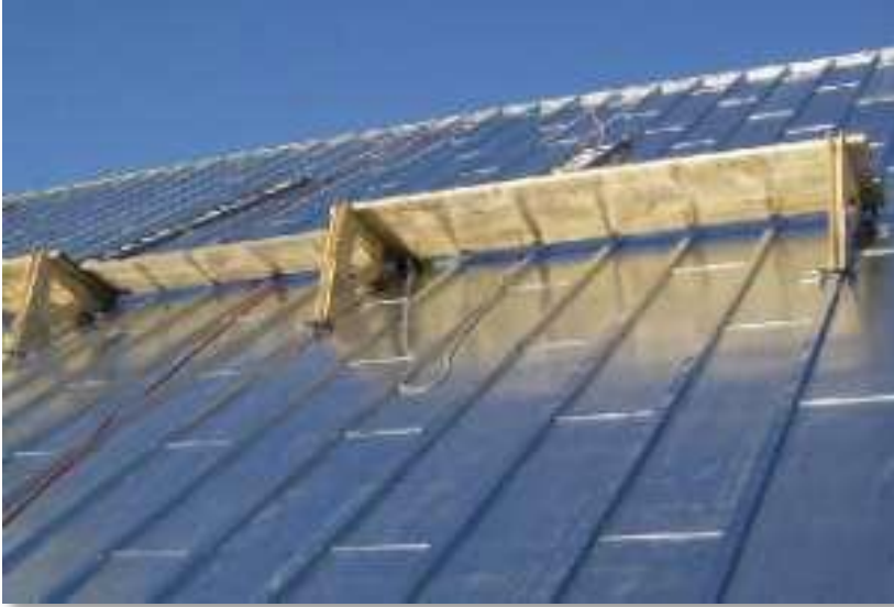
Figure 15 : Toiture en tôle à baguette
