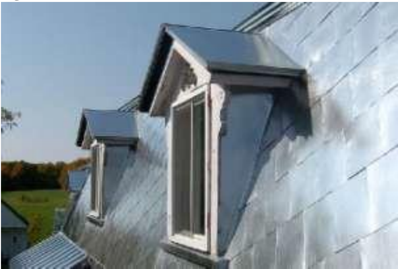
Figure 16 : Toiture à la canadienne
