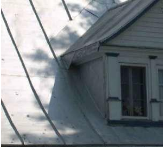
Figure 17 : Toiture en tôle pincée ou agrafée
