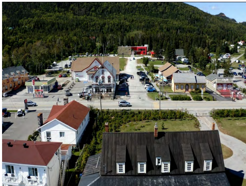
Figure 10 Intersection de la 132 et de l'accès au pavillon du Geoparc Source : Ville de Percé
